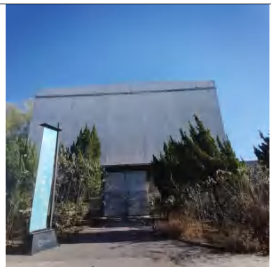
白墙工业厂房 2
