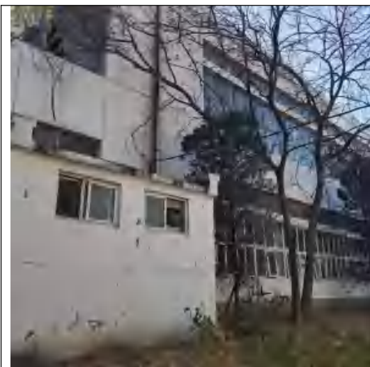
白墙工业厂房 1
